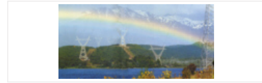
En 1976 Techint construyó la línea de alta tensión que unía Futaleufú con Puerto Madryn: 176 kilómetros de doble línea y 1.040 torres de soporte. Foto A.
