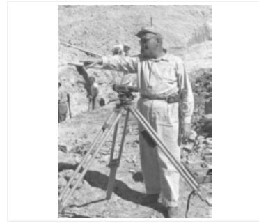
Medición del terreno durante la construcción del gasoducto "Presidente Perón", 1948.
