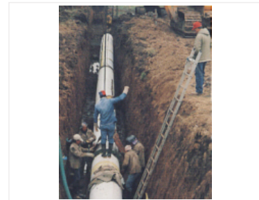
Tendido de tubos para el gasoducto "Loma de la Lata".
