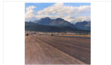
Pavimentación del aeropuerto de Ushuaia, 1983.
