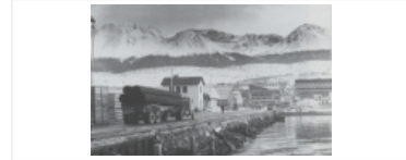
En Ushuaia, transporte de tubos para la construcción del gasoducto "San Martín".
