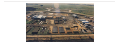
La central termoeléctrica "Loma de la Lata" se construyó en siete meses y medio: un plazo contractual que no había existido en Techint.
