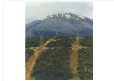
En 1976 Techint construyó la línea de alta tensión que unía Futaleufú con Puerto Madryn: 176 kilómetros de doble línea y 1.040 torres de soporte. Foto B.
