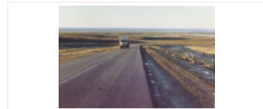
Pavimentación de la Ruta 3: 235 kilómetros entre Comandante Piedrabuena y Río Gallegos y 30 kilómetros entre Trelew y Puerto Madryn, 1983.
