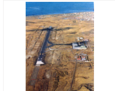
En Río Grande, Tierra del Fuego, Techint construyó en 1984 la pista de la Base Aeronaval.
